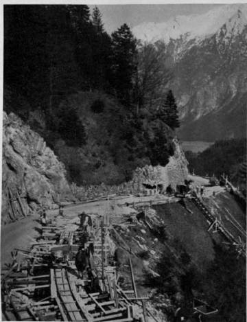
Ausbau der in die Deutsche Alpenstraße einbezogenen Straße Oberau—Ettal—Oberammergau
