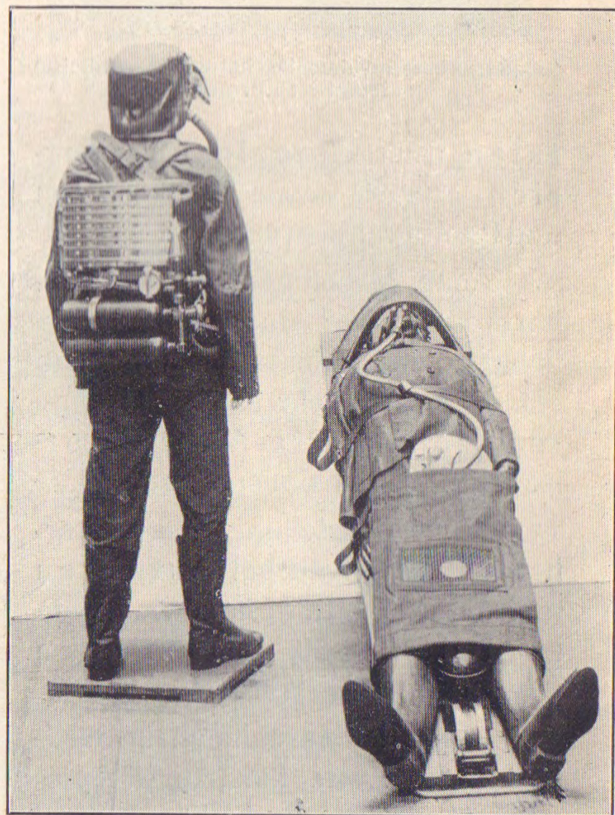
Figur mit Sauerstoffretungsapparat ausgerüstet; ein Verletzter zum Transport auf dem Schleifbrett, mit Sauerstoff-Wiederbelebungsapparat.
